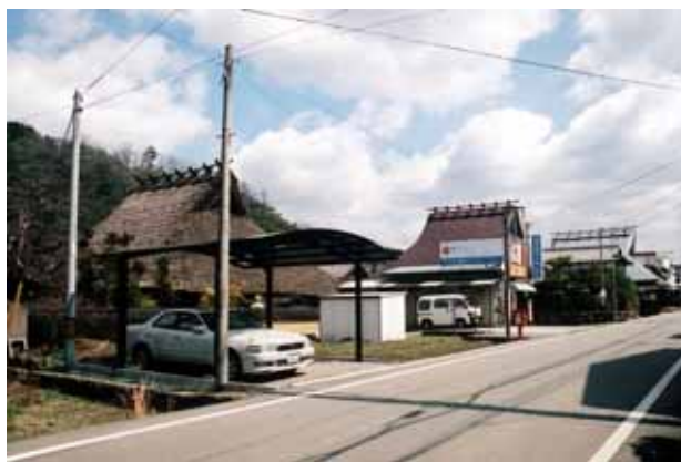
図 4.2-10 安口の町並み 手前の家は摂丹型民家で街道から後退している。
