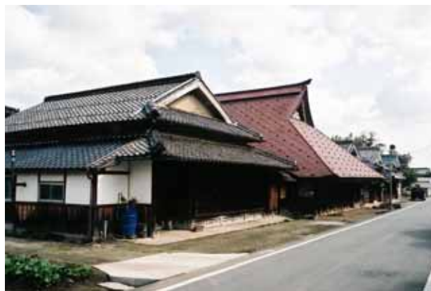
図 4.2-12 妻入茅葺の町並みが妻入瓦葺の町並みに変化する様子（八上）
