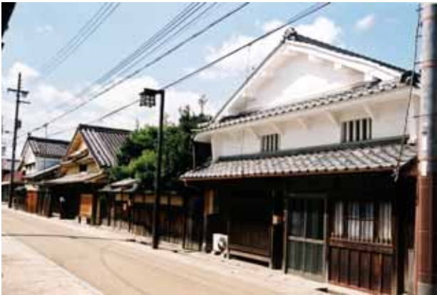
図 4.2-8 亀岡の町並み
